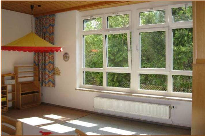
Es wurde ein Vollwärmeschutz mit 16 cm Styropor aufgebracht, die Fenster getauscht der Sockel isoliert und erneuert, der Eingangs- und Gartenzugangsbereich barrierefrei neu gestaltet. Dachrinnen und Abläufe wurden nach Bedarf getauscht. Auch wurde die gesamte Innenbeleuchtung auf den Stand der Technik und in einer dem Bedarf entsprechenden Qualität erneuert. Weiters wurden die Teppiche für beide Gruppen sowie die Garderobe für die
